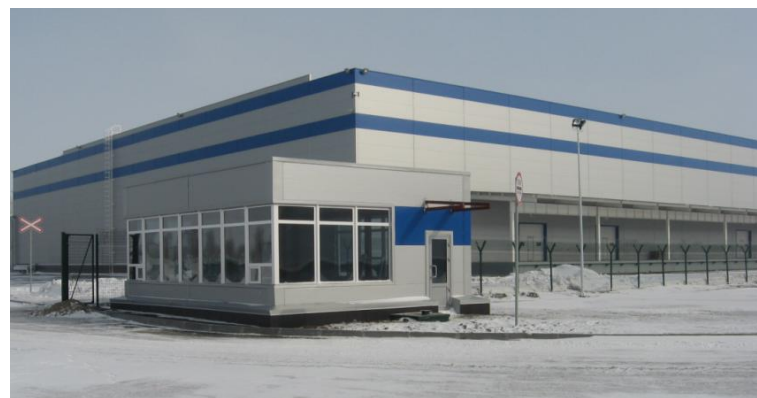
[строящееся здание завода]
