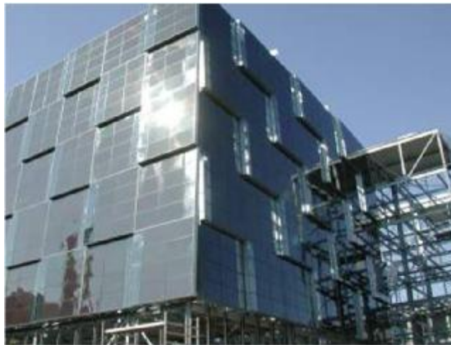
Gevel Zwolle, Netherlands
