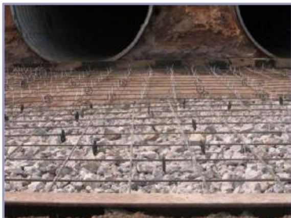
Рисунок 8. Сетка из композитных стержней «Гален», закладка на опытном участке
