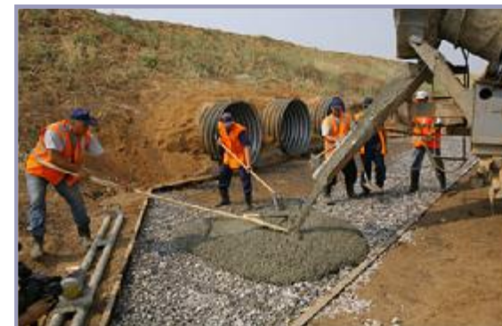
Рисунок 7. Укладка композитной сетки на опытном участке дороги Шали-Бавлы
